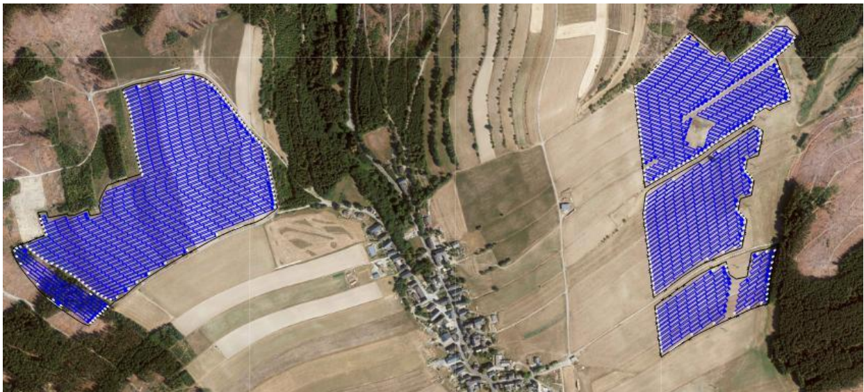
Abbildung 1: Übersicht der Anlagenfläche: Dargestellt sind die Modultische – Quelle Abbildung: Auftraggeber
